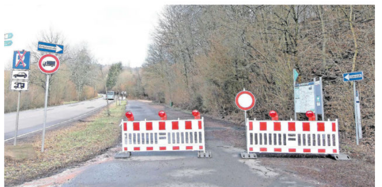
Eine Weile war der Parkplatz an der Talbrücke nun gesperrt. Jetzt sind Asphaltarbeiten angelaufen.
